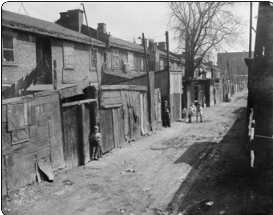
Figure 1 : Photo d'une ruelle dans Pointe-Saint-Charles en 1946. Crédits : Archives du Canada (Cote : PA-043877-1946)
