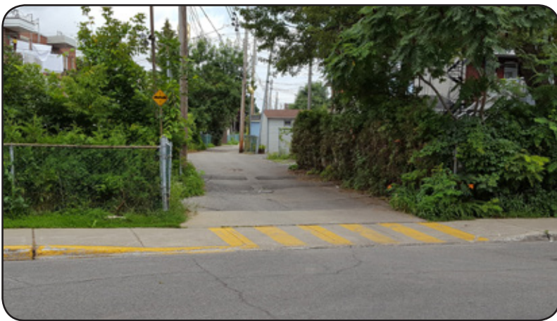
Figure 21 : Marquage au sol de type « traverse piéton » peint sur le trottoir et interdiction de stationner dans la case de stationnement adjacente à la ruelle. Crédit : REQ.
